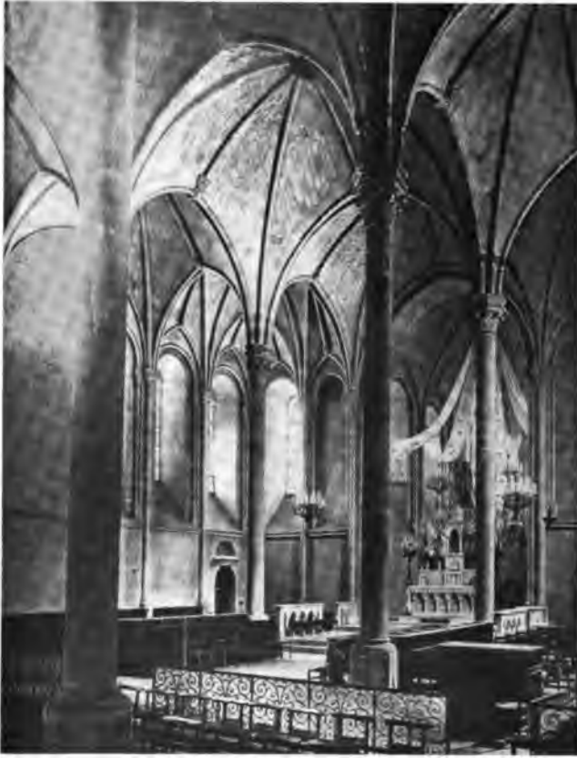
Fig. 141. -- Voûtes domicales sur chevet carré avec voûtes triangulaires de raccord aux angles sur le chœur de l'église Saint-Serge à Angers.
